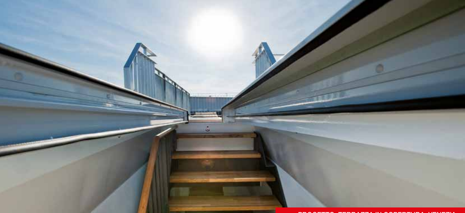
PROGETTO: TERRAZZA IN COPERTURA, VENEZIA
